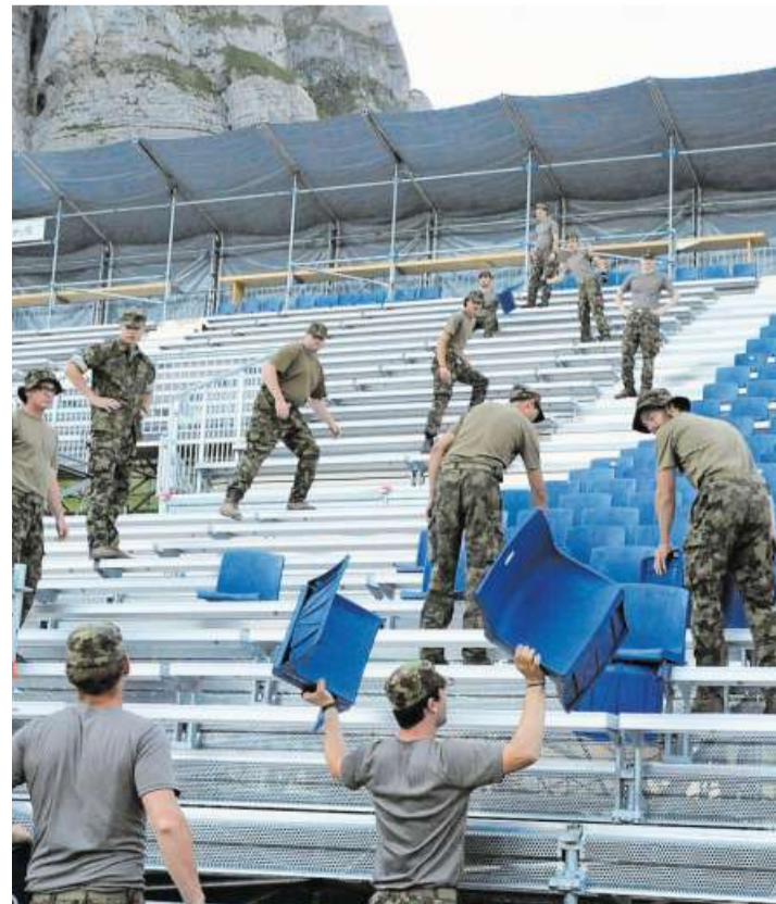
Die Armee ist mit rund 30 Mann vor Ort und hilft beim Aufbau.
